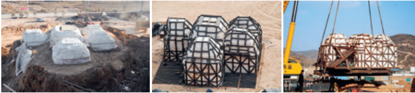
图3 墓葬壁画整体搬迁、打包和吊装
